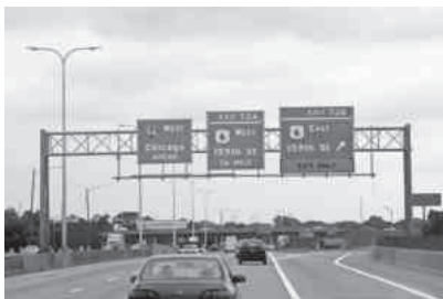
Fotografía 3.4 Las fuerzas paralelas del viento que actúan sobre los señalamientos de la carretera, pueden reducirse a una sola fuerza equivalente. La determinación de esta fuerza puede simplificar el cálculo de las fuerzas que actúan sobre los soportes del marco que sostiene los señalamientos.
